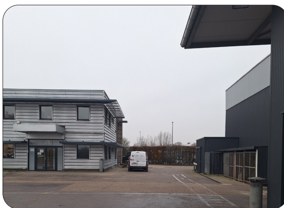
5 - Links kantoorgebouw, rechts de loods/werkplaats
