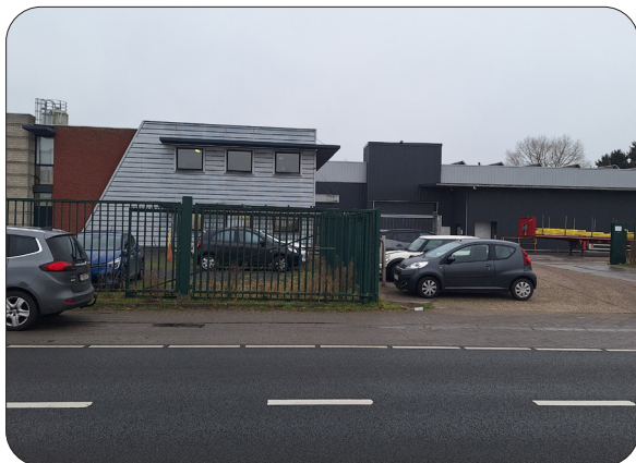
10 - Kantoorgebouw met rechts de loods/werkplaats
